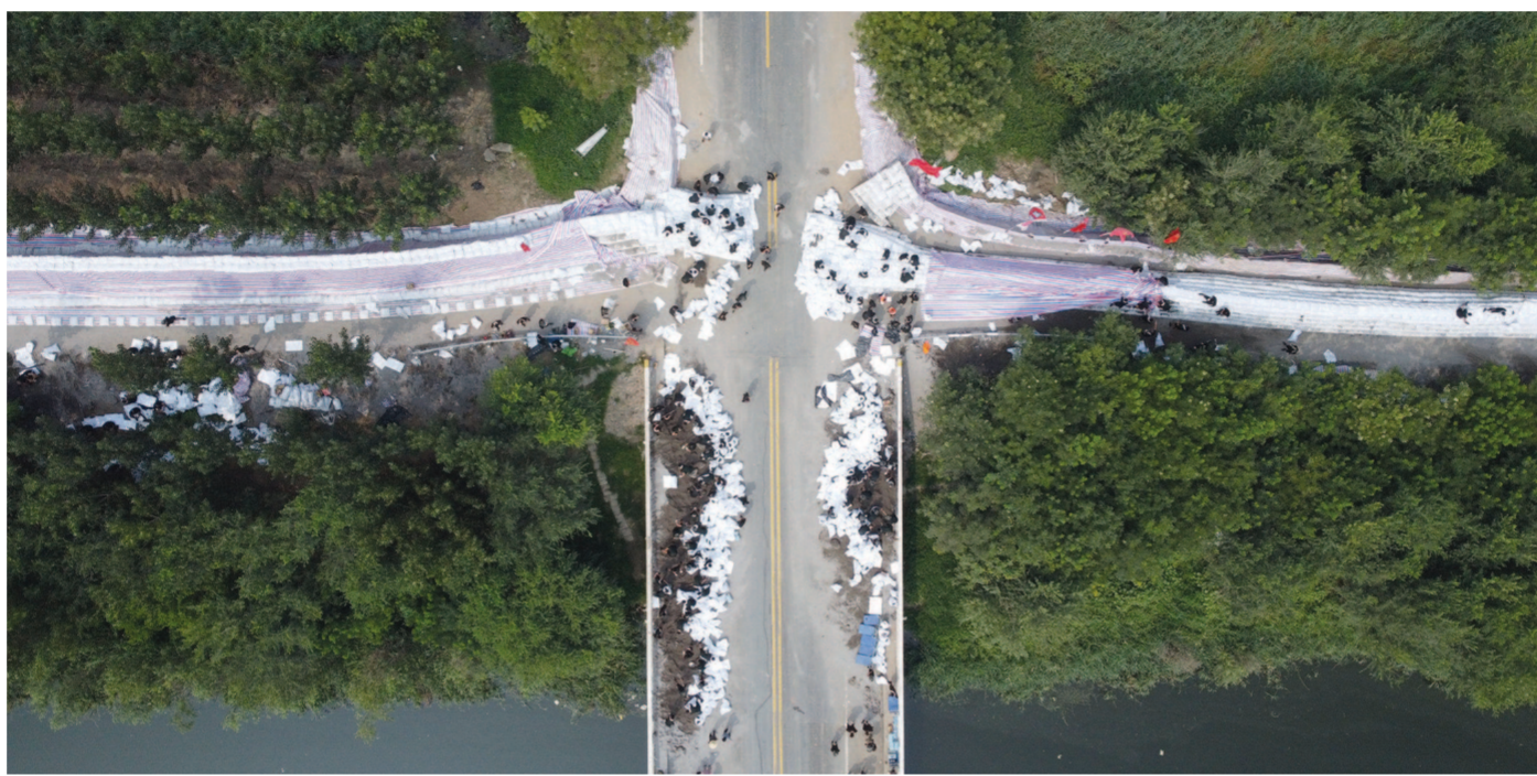
8月10日,武警第一机动总队某支队官兵在大清河支渠桥处抢筑堤坝(无人机照片)。新华社记者 赵子硕摄
