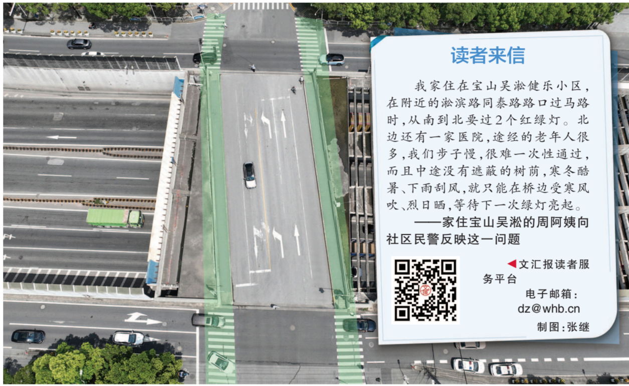
居民从淞滨路同泰路路口过马路时,南北向要过2个红绿灯,绿灯时长调整前,许多老人很难一次性通过。(受访者供图)
