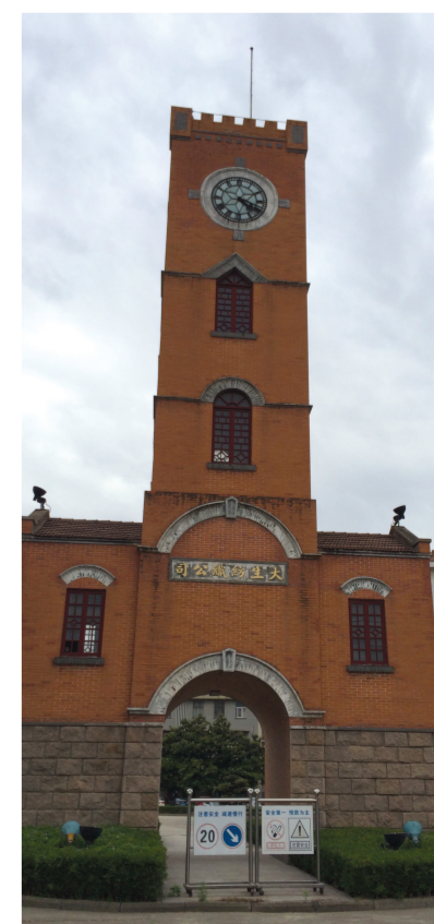
▲南通大生纱厂入选“第二批中国20世纪建筑遗产”名录。图为大生纱厂钟楼。
