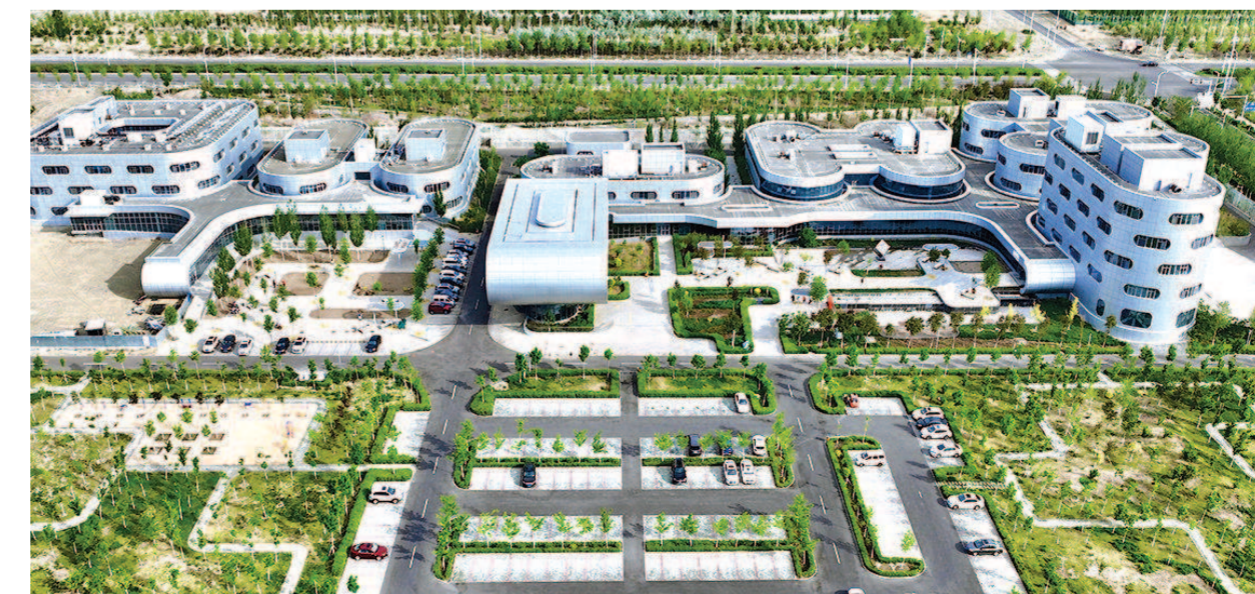
克拉玛依云计算产业园一角。目前，该园区已经吸引180余家企业入驻，建成5座大型数据中心。
