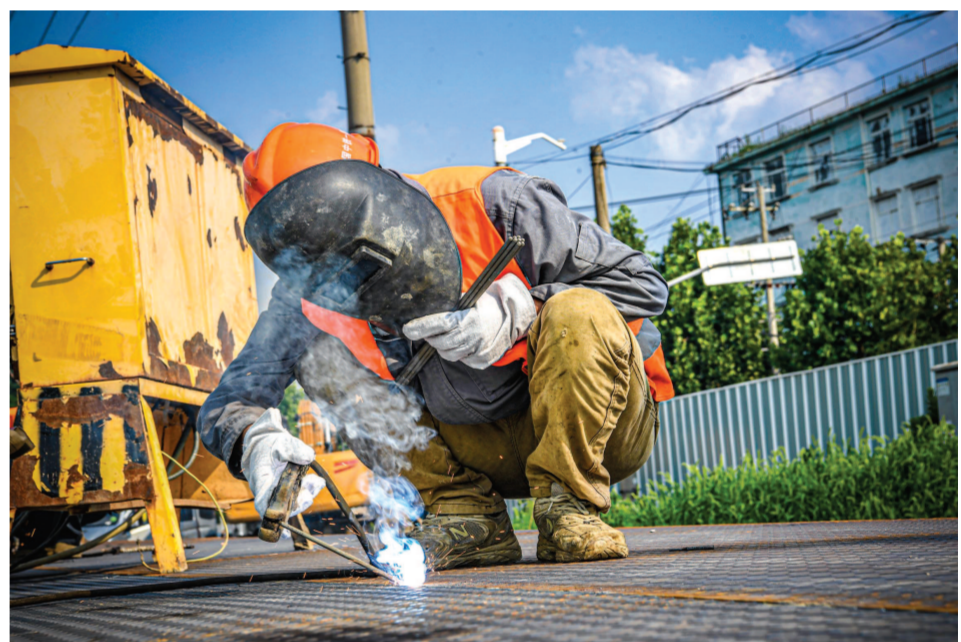
▲轨交18号线二期通南路站施工现场,工人们全力以赴为主体基坑开挖做好施工准备。 本报记者 张伊辰摄
