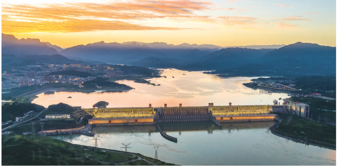
7月4日在湖北省宜昌市拍摄的夕阳映照下的三峡水利枢纽工程（无人机照片）。新华社发（郑家裕摄）
