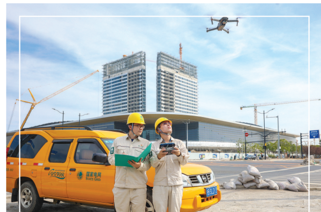
临港能源服务中心在103顶科社区开展区域电力一体化配套建设。(采访对象供图)
