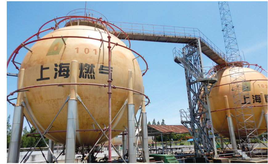
在液化气瓶罐装企业,储气罐24小时专人监控。
