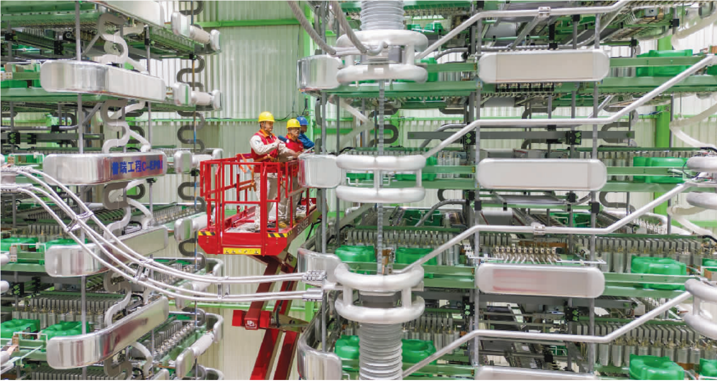
国网上海电力工作人员对新组装的可控换相换流阀进行调试验收。
