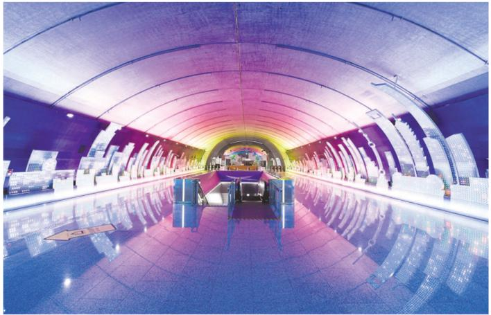
轨道交通15号线吴中路站,设计上开创性地采用了预制大跨叠合拱型结构,将上海浦江两岸天际线以76米长画卷呈现于站厅拱顶。 本报记者 张伊辰摄
