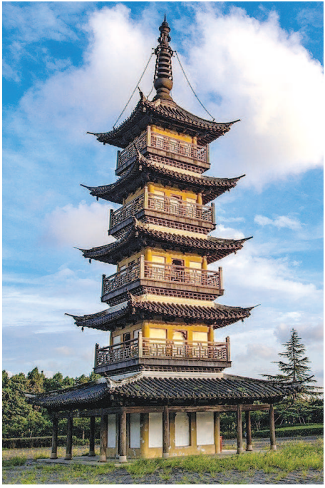
泖塔为砖木结构，共有5层，平面呈方形，塔基边长8.63米，塔身主体高度20.6米，总高28.2米。（青浦区供图）
