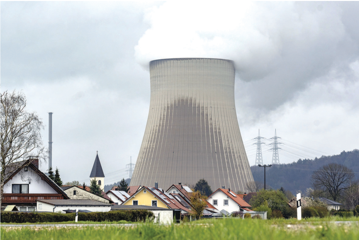
15日,伊尔萨2号、内卡韦斯特海姆、埃姆斯兰三座核电站与电网分离,标志着德国核电站商业发电时代的结束。图为位于德国巴伐利亚的伊尔萨2号核电站的冷却塔。
