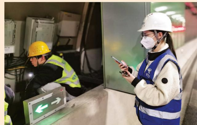
近日,上海电信启动地铁区域网络质量第一轮攻坚项目。目前,已经完成了11号线江苏路站、6号线云山路站、17号线虹桥火车站等7个站点的提质任务,通过开断排摸、重新布放馈线等技术手段,有效地改善了以上站点和区间的无线网络质量。作为今年网络提质系列攻坚项目,上海电信攻坚团队将不断排摸研究,力争早日完成上海全网地铁隧道的无线网络提质。摄影报道 杨鑫
