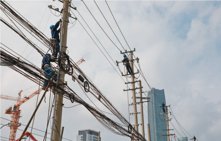
工人们正在清理蛛网般的架空线。
