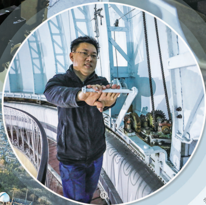
④2005年圆顶最后一次打开时,望远镜圆顶因齿条锈蚀磨损而卡住,从此无法灵活转动。经过这次大修之后的穹顶让上海天文台佘山科普教育基地负责人汤明海直言“开起来轻松多了”。
