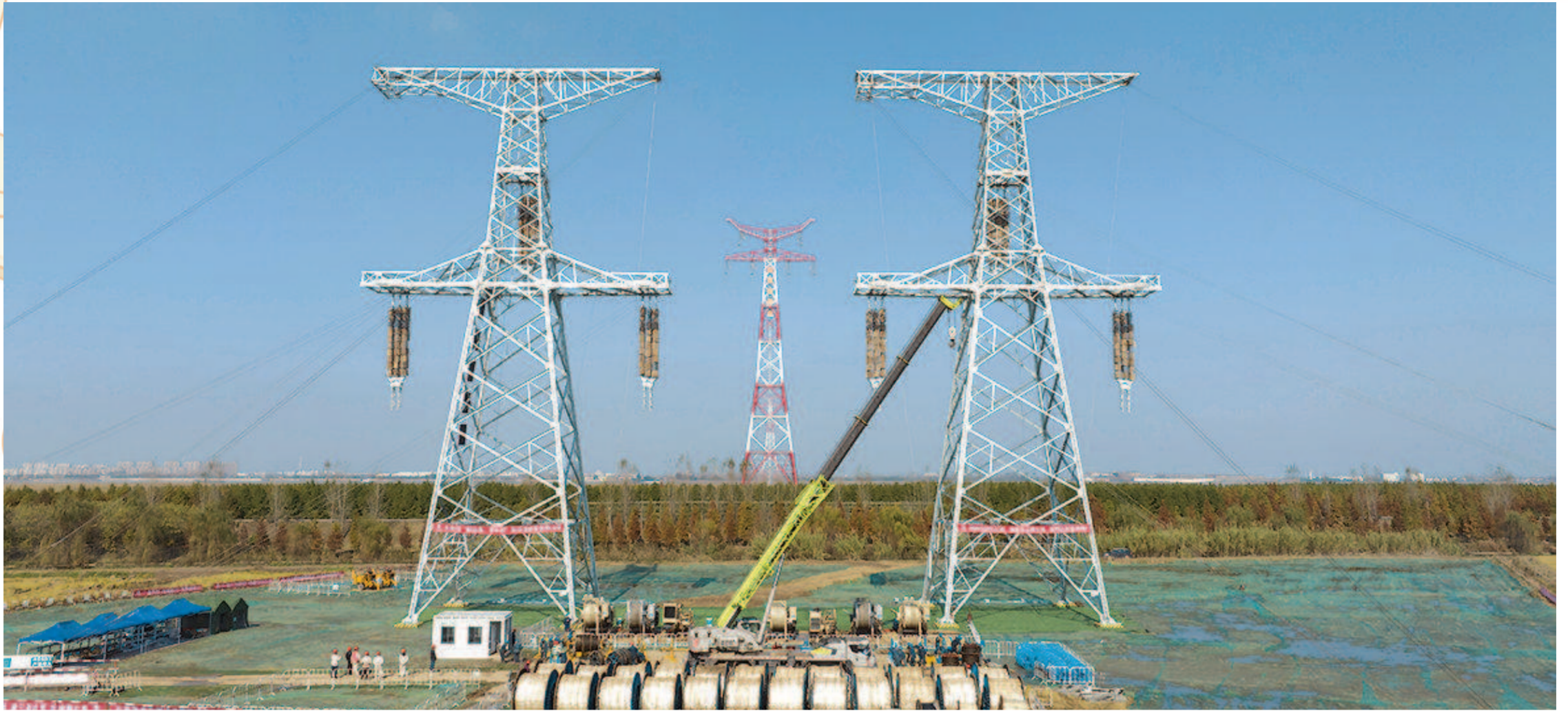
在东湖1崇明50千伏线路工程（上海段）智能张力场，上海送变电公司施工人员进行放线施工。（国网上海市电力公司供图）
