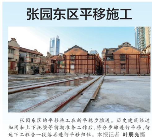
张园东区的平移施工在新年稳步推进。历史建筑经过加固和上下托梁等前期准备工作后,将分步进行平移,待地下工程告一段落再进行平移归位。本报记者 叶辰亮摄
