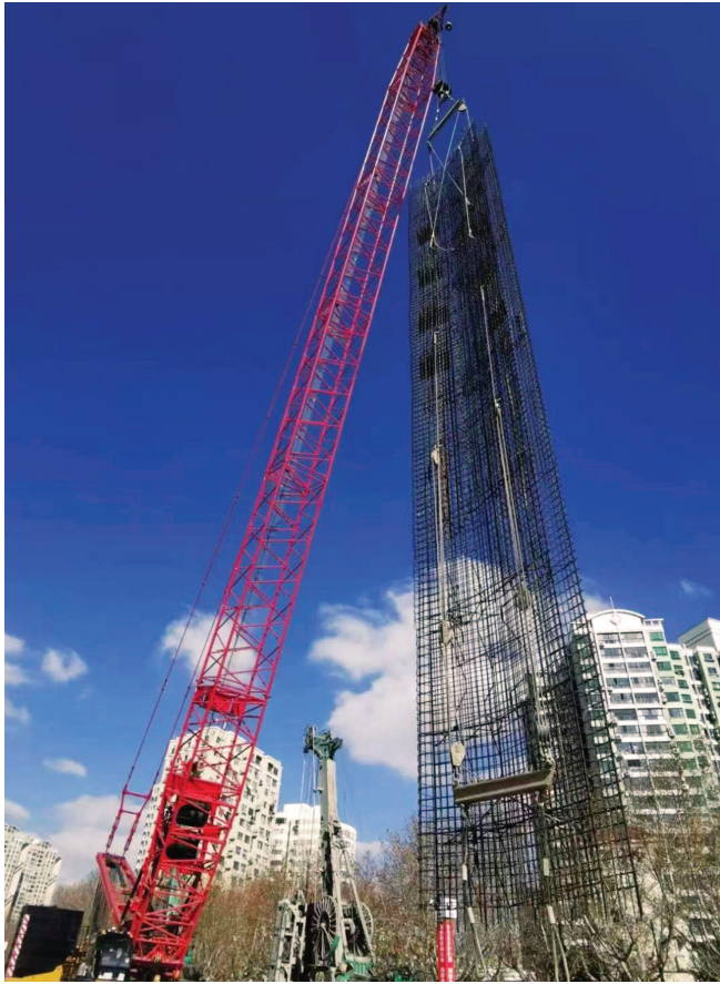
随着钢筋笼平稳入槽,轨交23号线一期工程首个车站完成围护结构封闭。(采访对象供图)
