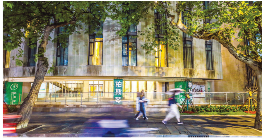
上音汾阳路校区整体提升工程基本完成。 本报记者 袁婧摄
