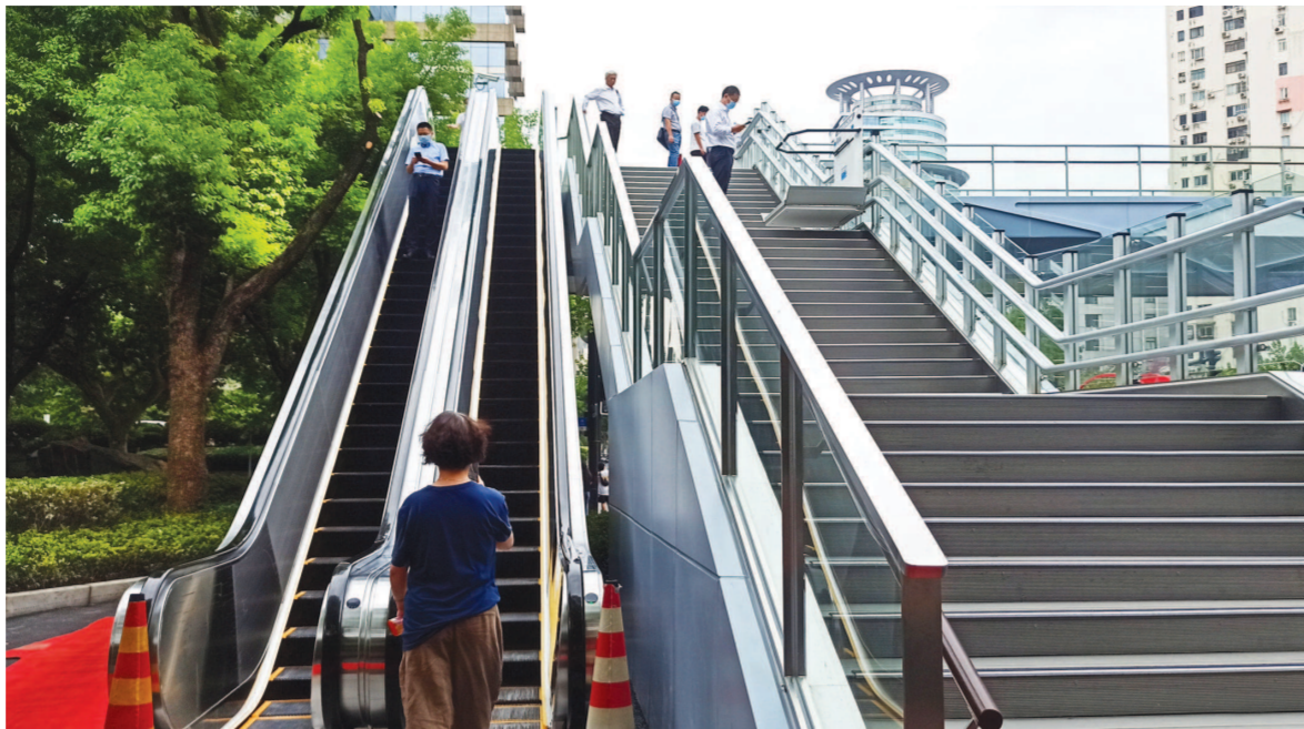
宛平路新建成的天桥装有上下双向自动扶梯,并配有残疾人升降梯,极大方便了老年人和残疾人出行。 本报记者 赵立荣摄
