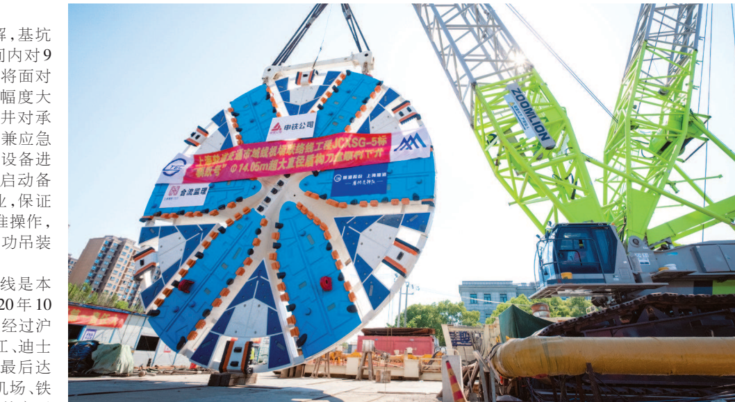
国产超大直径盾构“骐跃号”已整装待发，其刀盘直径达14.05米。
