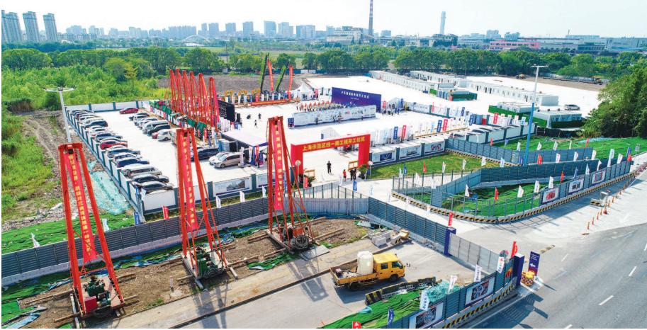
上海示范区线一期工程青浦新城站开工点。
