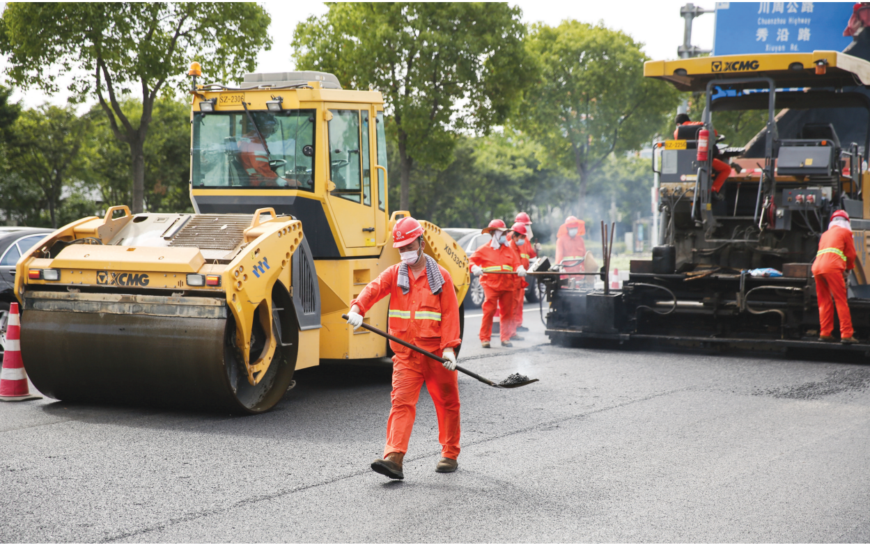
养护工顶着烈日、脚踩滚烫沥青，一丝不苟养路护国。 王雨青摄
