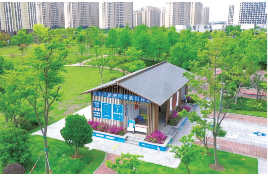
设在金山卫镇仓河公园里的便民采样点,既方便百姓需要,又避免了人群聚集。
