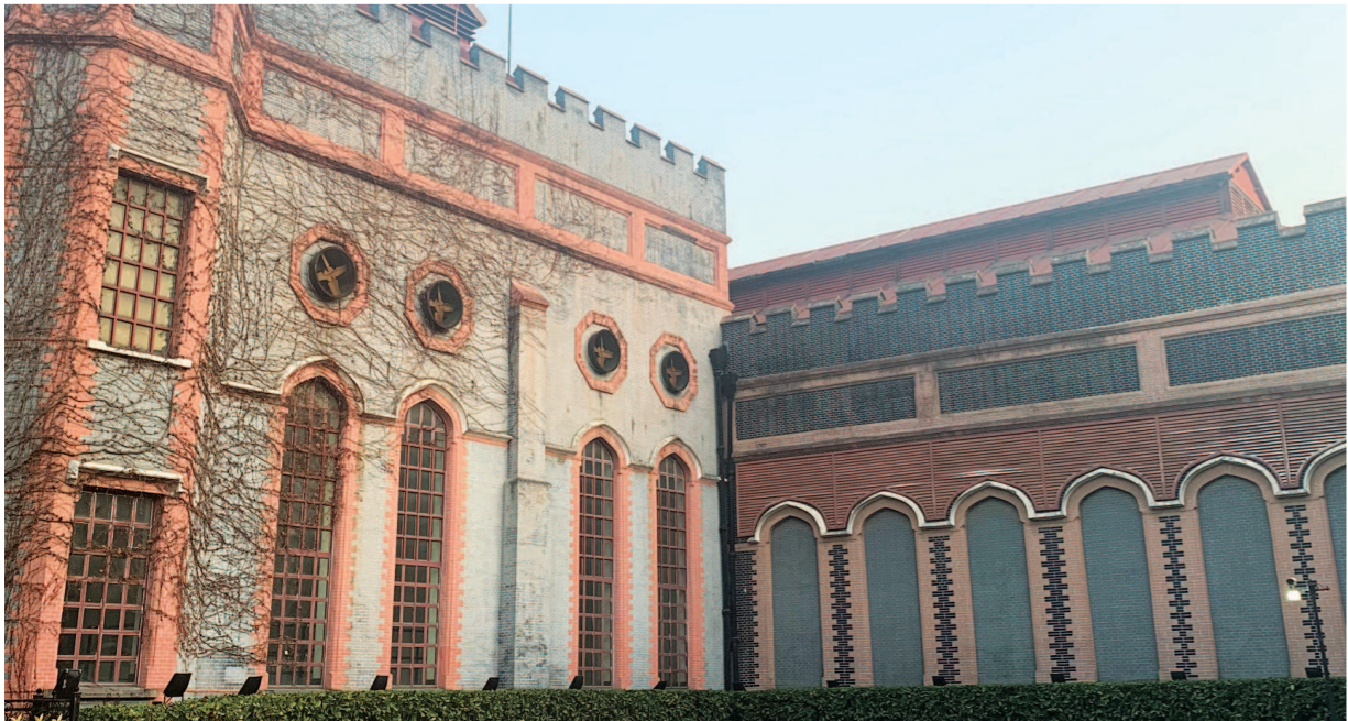
▲ 杨树浦水厂的建筑立面划分 陈洁摄
