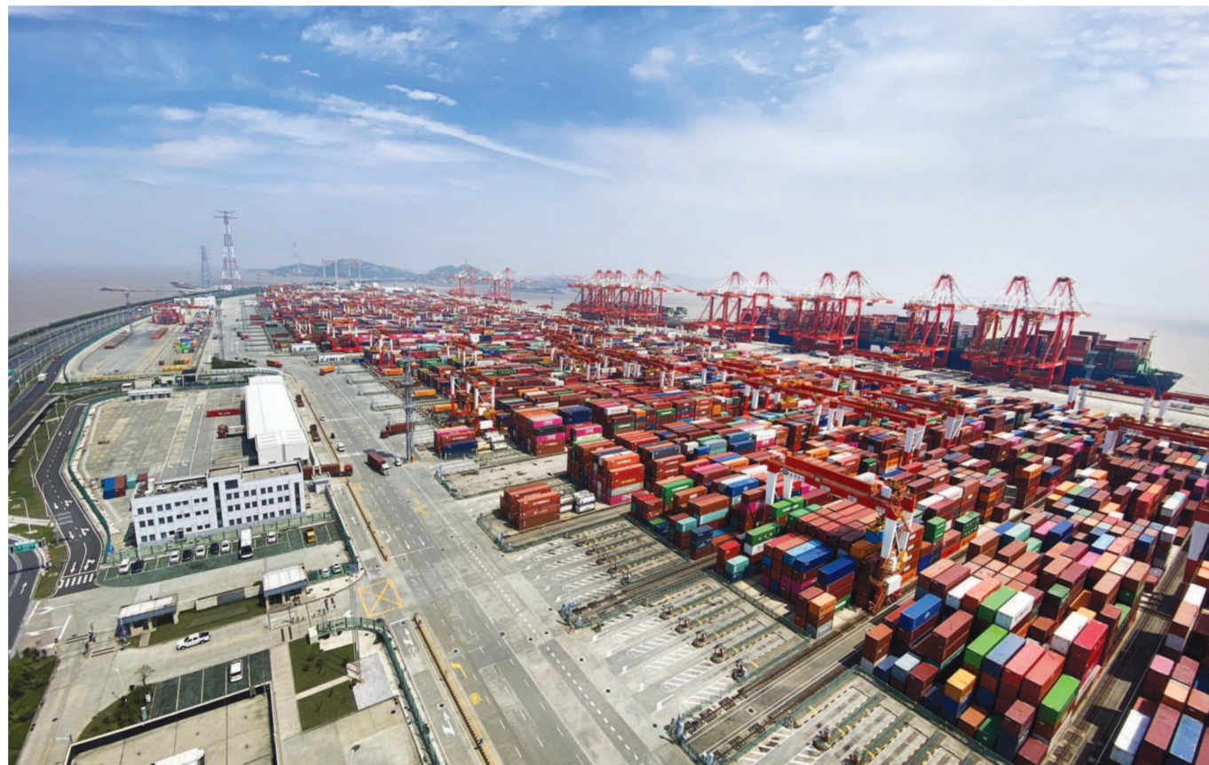
上海洋山港四期自动化码头是全球单体规模最大、智能化程度最高的自动化集装箱码头。
