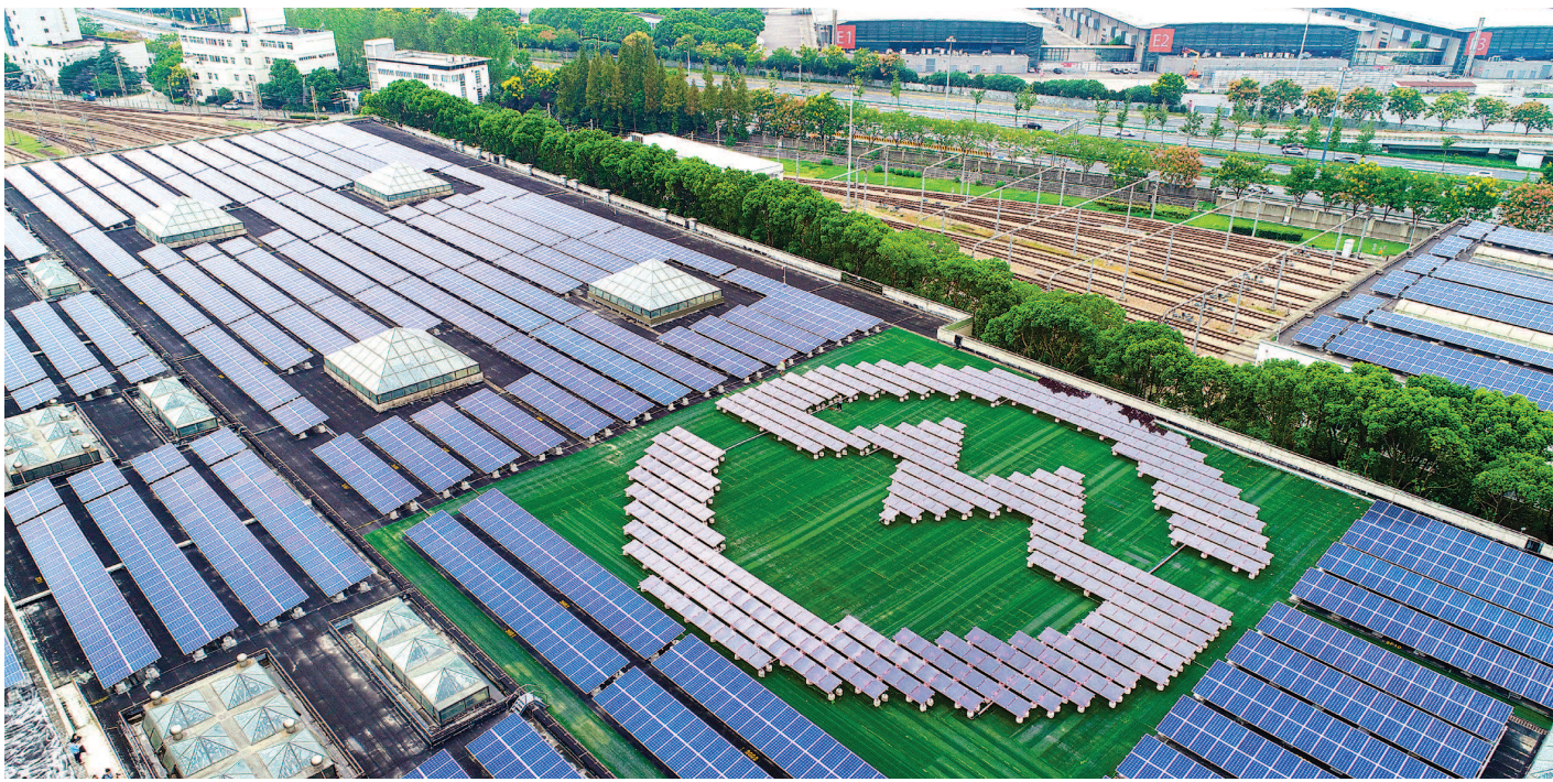
在浦东龙阳路车辆基地，地铁车库的屋顶藏着一座发电厂：近1.3万块光伏板构成的光伏发电项目，既利用了屋顶闲置空间，也为地铁列车提供绿色清洁能源。本报记者 张伊辰摄
