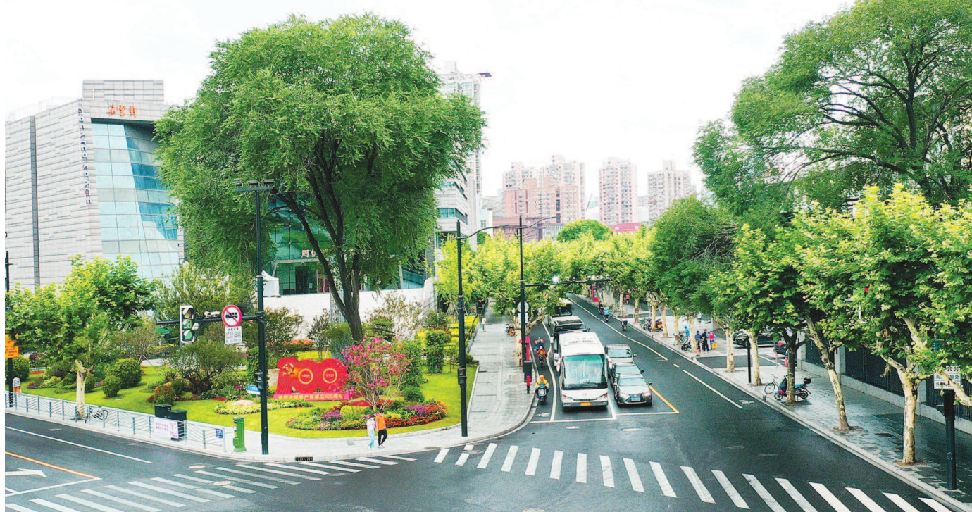
徐汇区实施龙陵周边环境综合整治项目,形成具有集中度和显示度的无架空线示范区。
