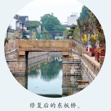
修复后的东板桥。
