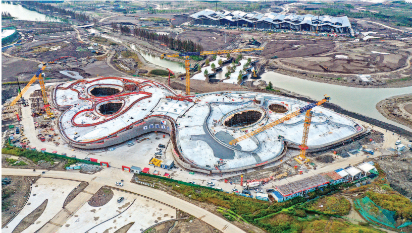
近日,花博会世纪馆项目顺利完成结构封顶。本报记者 邢千里摄
