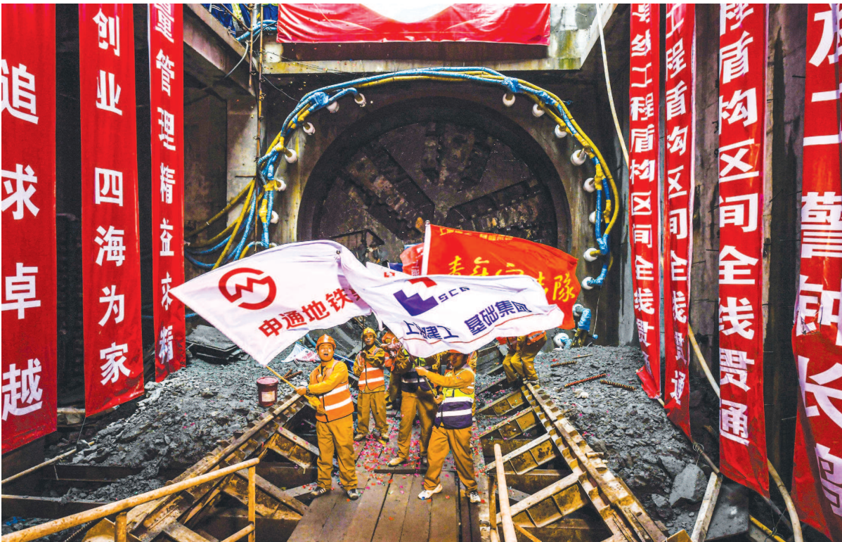
昨天上午，轨交18号线一期工程全线结构贯通。
