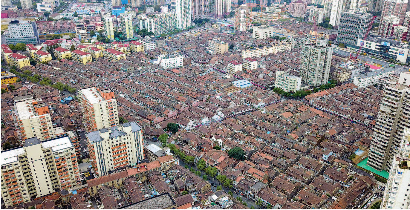
空中俯瞰东余杭路(一期)旧区改造项目。
