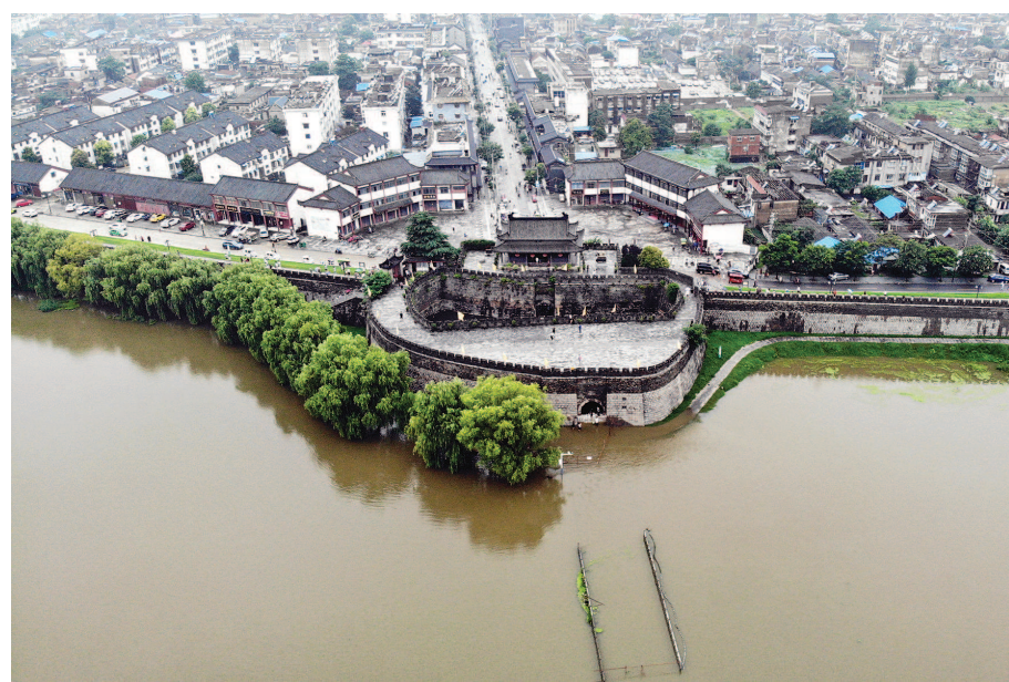
受近日强降雨影响,安徽省寿县古城护城河水暴涨,为防止河水倒灌进城内,寿县防汛抗早指挥部决定从7月18日12时起封堵县城东闸门。图为寿县县城东闸门(无人机照片)。
