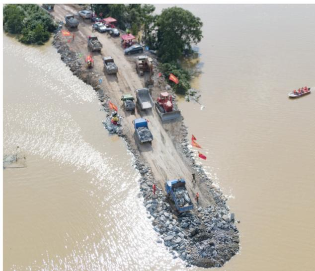
▲7月8日晚，江西省鄱阳县鄱阳镇问桂道圩堤发生漫决。险情发生后，中国安能第二工程局迅速调集抢险人员、工程装备前往决口现场，打响防汛抢险阻击战。截至7月12日下午，决口封堵进度已经过半。图为问桂道圩堤施工现场(7月12日摄，无人机照片)。
