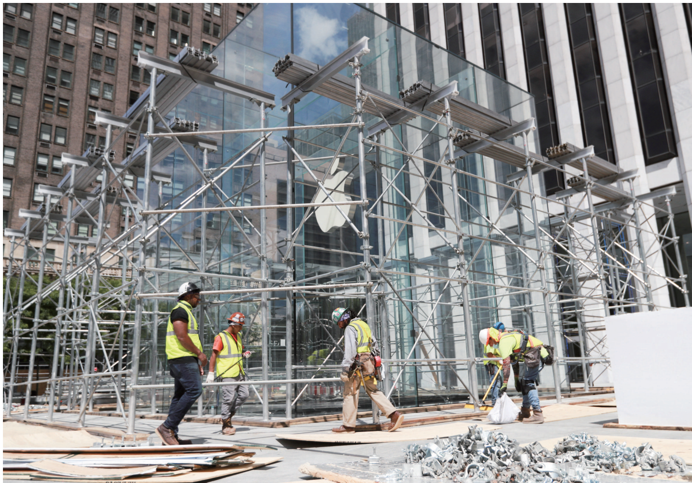
纽约市8日开始“解封”,进入经济重启第一阶段。图为6月12日,在纽约第五大道,工人们拆除一家商店外的脚手架。新华社发
