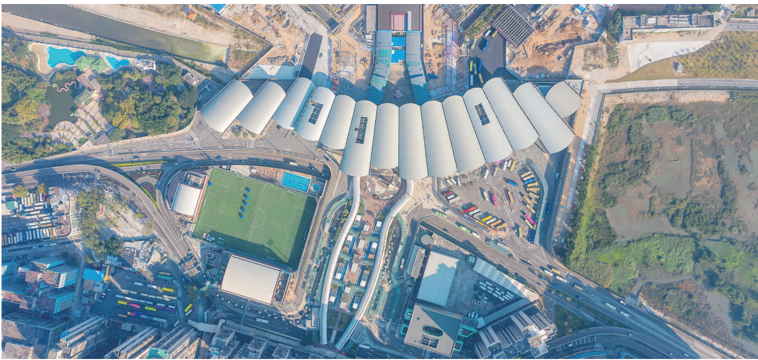
无人机拍摄的澳门关闸口岸。
