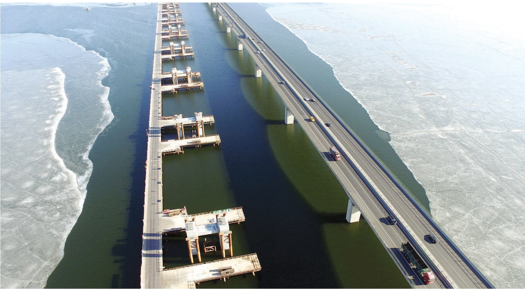
2017 年 2 月 14 日航拍的横跨官厅水库的京张高铁特大桥（左）与京张高速公路特大桥。京张高铁是北京冬奥会交通配套工程。
