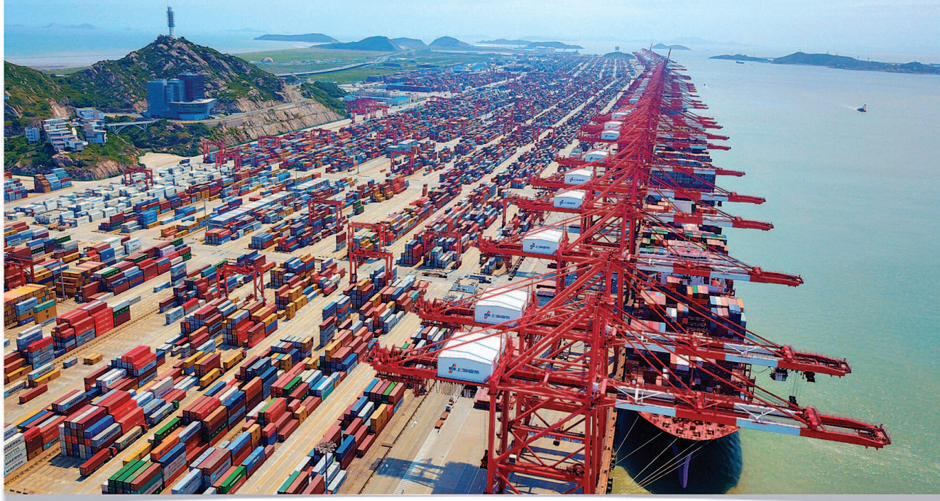
桥吊一字排开,集装箱被迅速吊移放下,车流不息,繁忙的码头现场内却“空无一人”,上海自贸区洋山四期以全球最大的规模和体量成为自动化码头的“集大成者”。 本报记者 赵立荣摄
