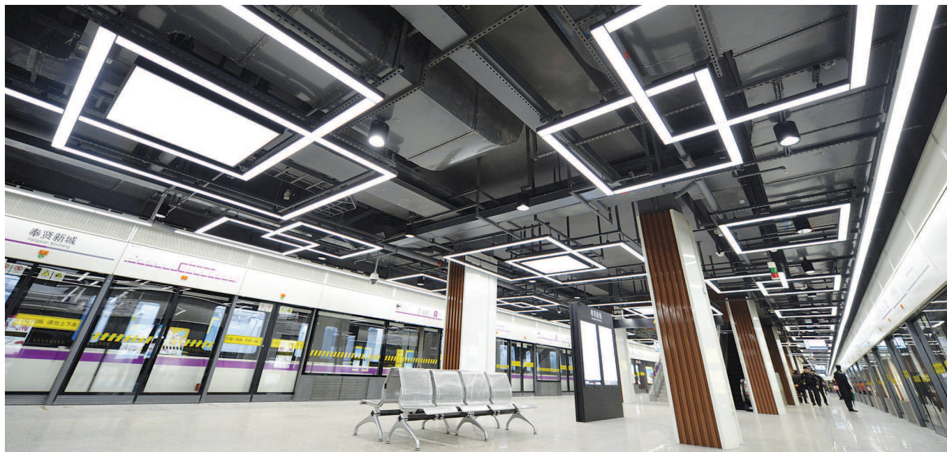
灯饰别致的轨交5号线南延伸段的奉贤新城站。
