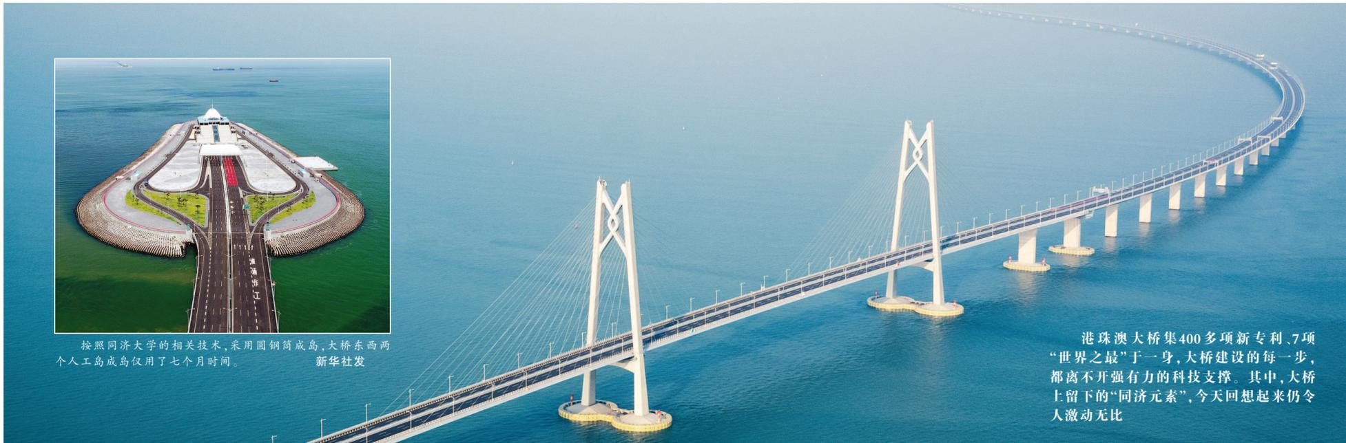
按照同济大学的相关技术,采用圆筒钢成岛,大桥东西两个人工岛成岛仅用了七个月时间。 新华社发
