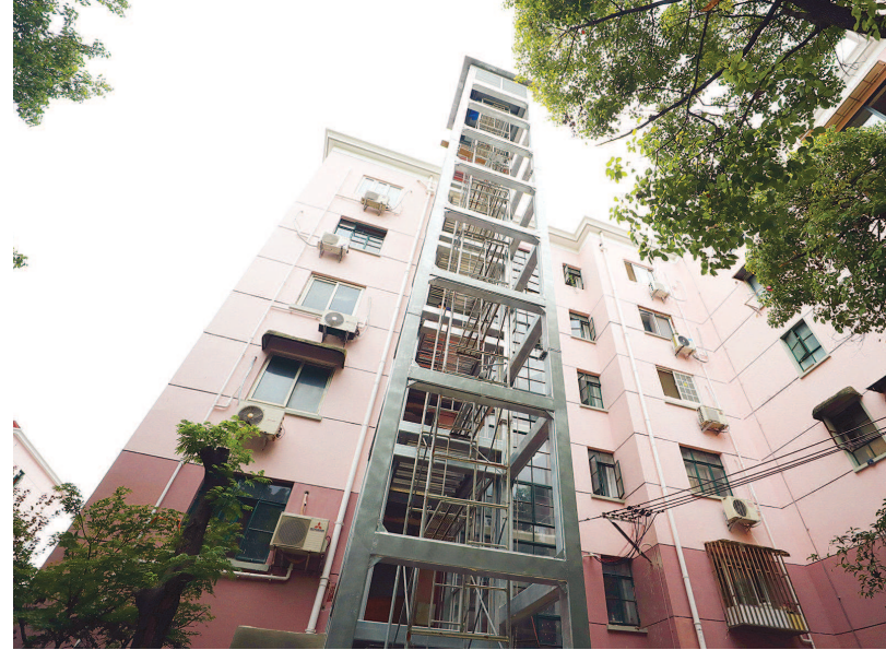
长宁新泾六村部分居民楼加装电梯,工程正在有条不紊地进行中。 本报记者 袁婧摄
