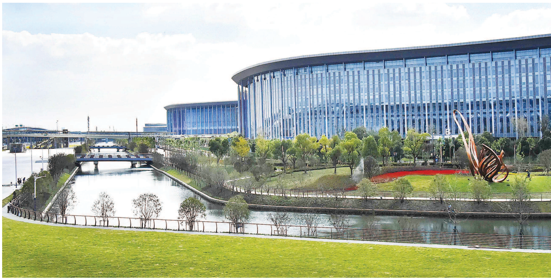
国家会展中心(上海)周边道路、河道改造及绿化工程已顺利完工。
