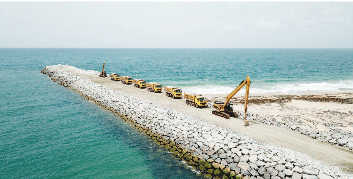
图为 2018 年 3 月 29 日在尼日利亚拉各斯州莱基深水港拍摄的防波堤。莱基深水港一期投资建设两个集装箱泊位。一期工期约 3 年,由中国港湾承建。新华社发
