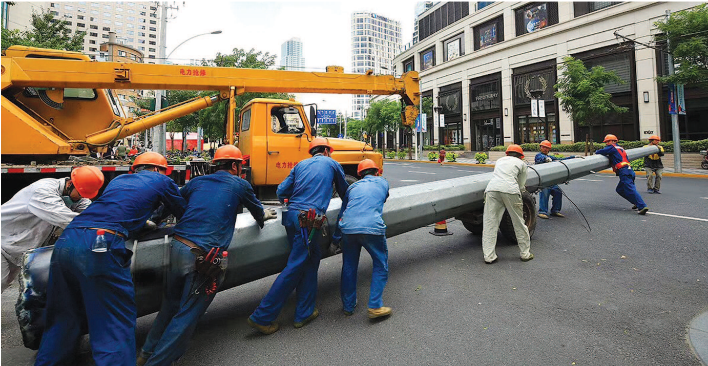
工人合力拔除推走石门一路上的电线杆。
