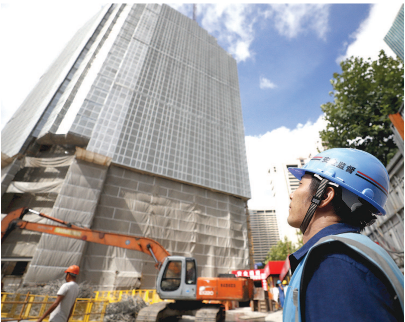
安全监督员正在对锦沧文华楼宇改建工程工地开展高空坠物检查。 本报记者 袁婧摄
