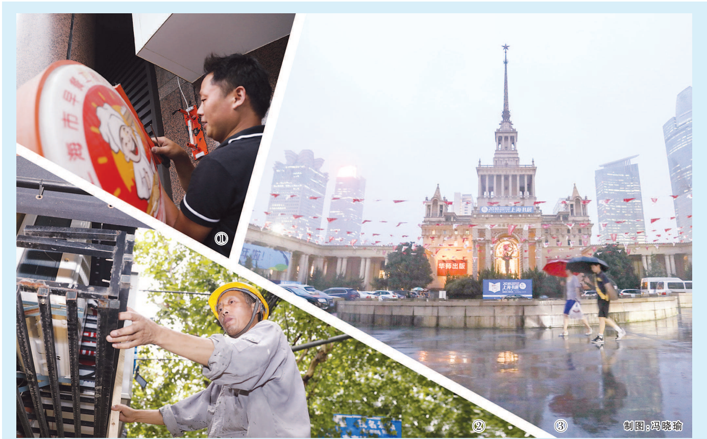
①专业人员拆除存在安全隐患的广告牌。本报记者 袁婧摄 ②专业人员对道路上的空调外机进行加固。本报记者 袁婧摄 ③上海书展启动紧急防台预案，组委会对展馆所有广告牌进行全覆盖排查，存在安全隐患的广告牌一律拆除。本报记者 叶辰亮摄
