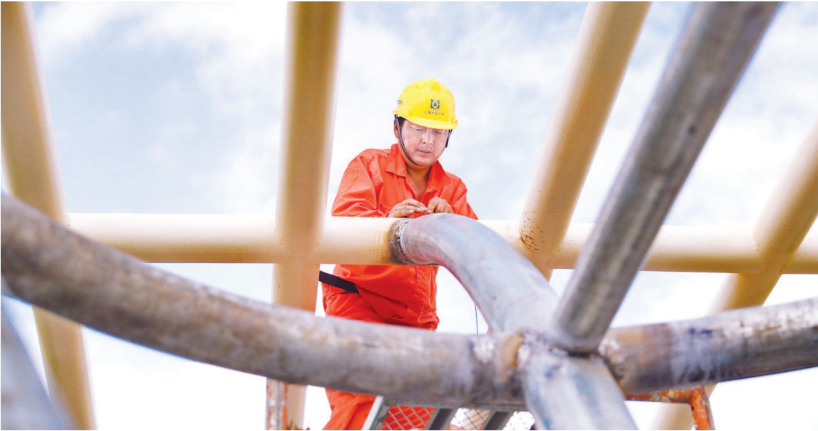
国家会展中心(上海)二层席席延伸工程施工人员冒着酷暑加紧建设。
