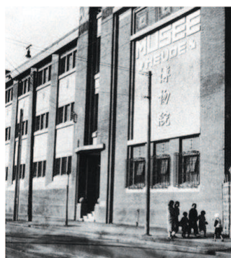
震旦博物院大楼
