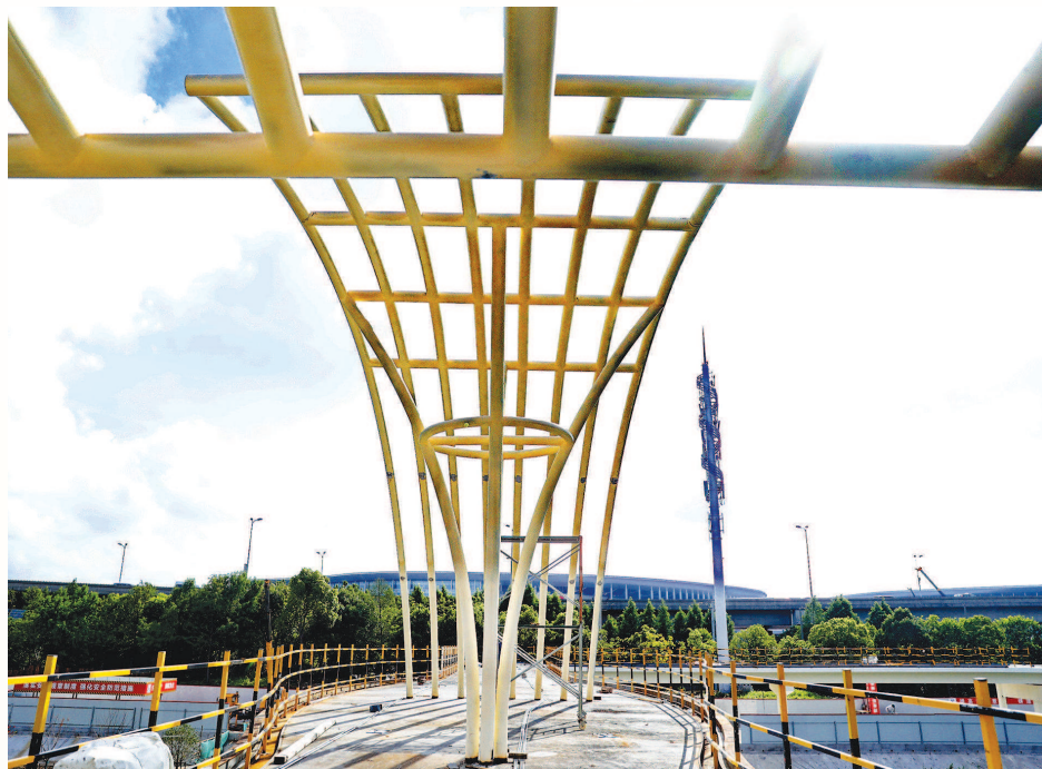
国家会展中心(上海)二层步廊延伸工程正在加紧建设中，“飞鸟”造型初具雏形。
