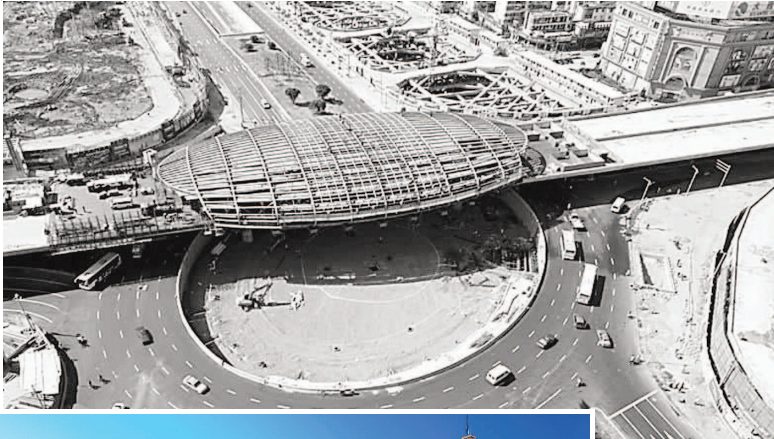
▲2005年6月，五角场环岛下沉式广场立交景观工程，主题为“上海科技之门”的钢结构彩蛋第一幅上拱梁构件吊装拼装 傅国林 摄
