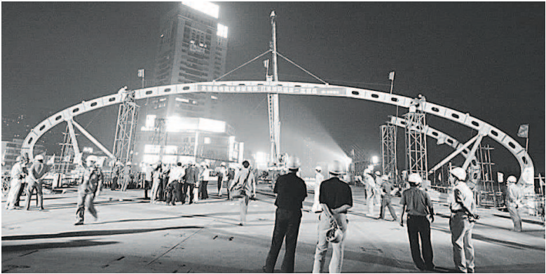
▲2005年6月，五角场环岛下沉式广场立交景观工程，主题为“上海科技之门”的钢结构彩蛋第一幅上拱梁构件吊装拼装 傅国林 摄
